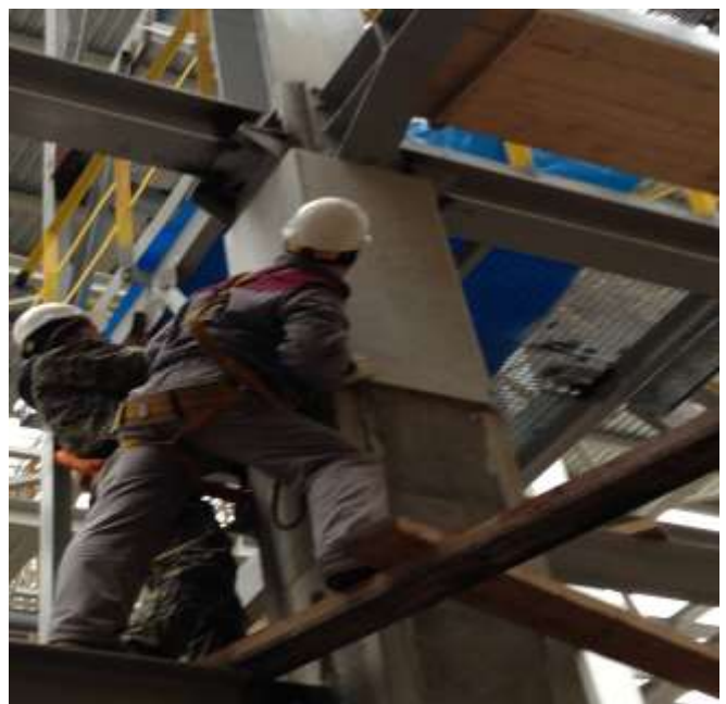
Выполнение огнезащиты металлоконструкций на НПЗ ТАНЕКО, г. Нижнекамск, 2013-2017 г.
