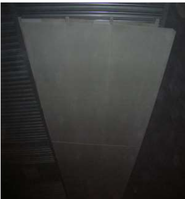
Огнезащита Рокского тоннеля, Северная Осетия, 2013-2014 г
