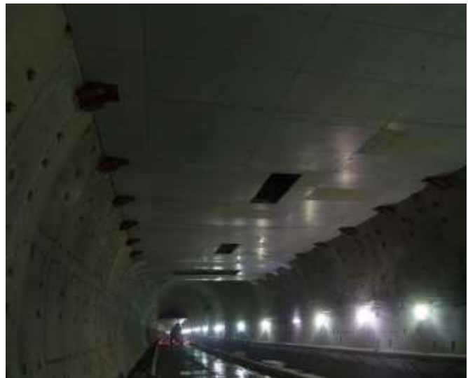
Огнезащита тоннеля №2 автодорожного Совмещенной дороги Адлер-Алпика-Сервис, г. Сочи 2012-2013 г.
