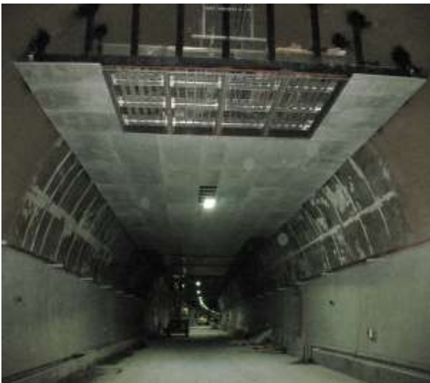
Огнезащита тоннеля №1 Дублера Курортного проспекта , г.Сочи, 2011-2012 г.
