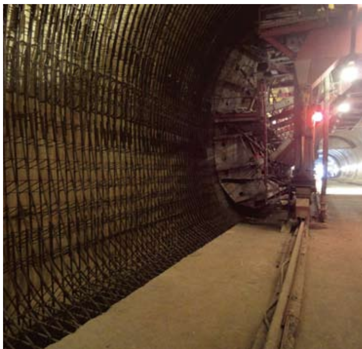
Рокский тоннель во время реконструкции
