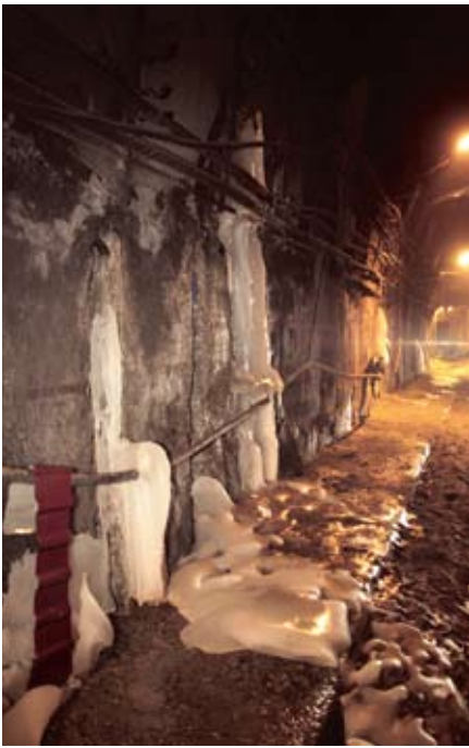
Рокский тоннель до реконструкции
