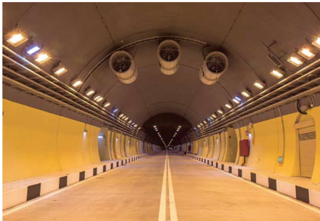
Рокский тоннель после реконструкции
