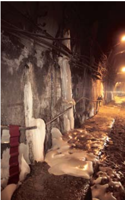
Рокский тоннель до реконструкции
